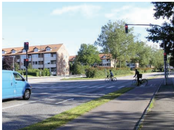
Ilustrační příklad: Aarhus (Dánsko), Vestre Ringgade – jednosměrný pás pro cyklisty je od chodníku oddělen obrubou
