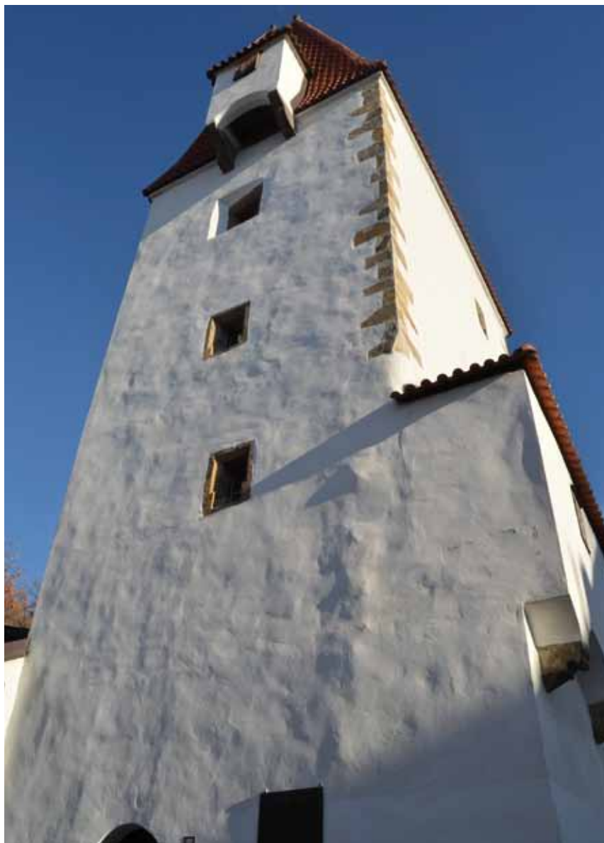
▲ Západní stěna věže Rabenštejnu – při bočním nasvícení jsou patrné hrboly jako stopa po hradbě odbourané v roce 1882.
