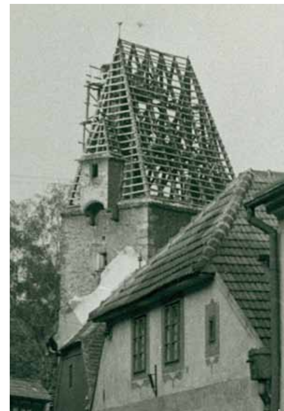
► Pozdně gotický krov věže Rabenštejnu při výměně krytiny v padesátých letech 20. století.
