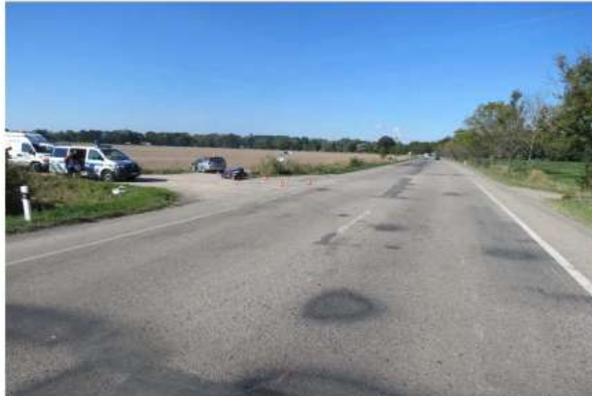
1. Celkový pohled na místo dopravní nehody v k.o. Bavorovice, sil. II. tř.č. 105 ze směru od obce České Budějovice směrem na obec Hluboká nad Vltavou.
