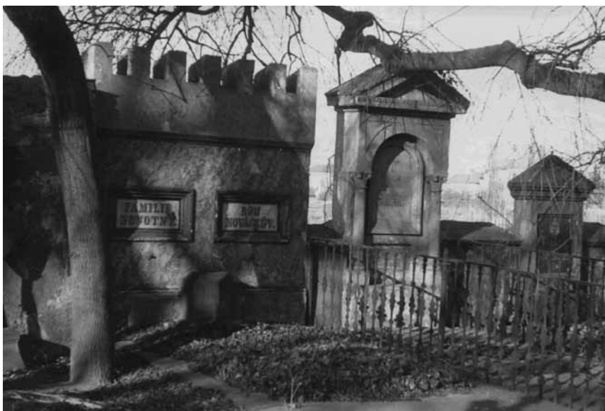
▲ Hrobky u severní zdi hřbitova v padesátých letech 20. století.
