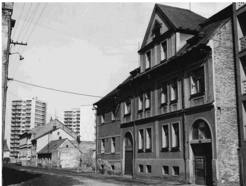
▲ Březen 1971: domy za Koldomem očekávají naplnění svého osudu.
