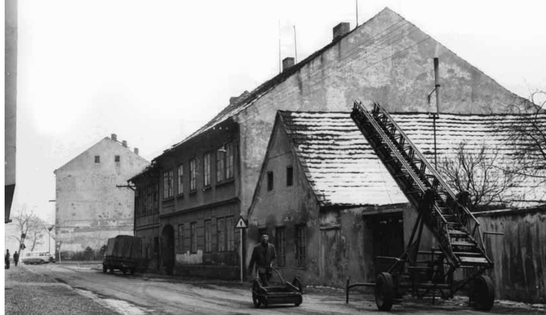
▲ Vystěhované domy ve Staroměstské ulici před demolicí.
