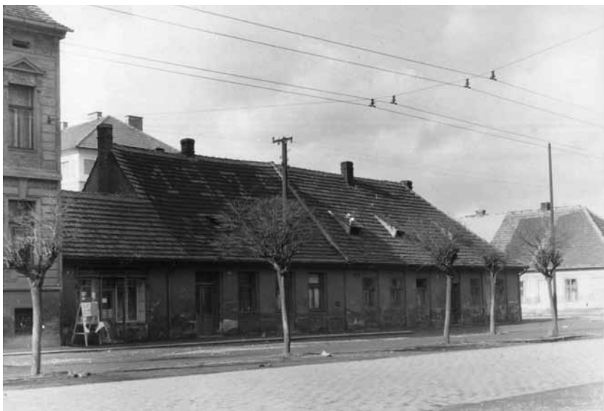
▲ Domky čp. 181 a 182 na Pražské třídě mezi Pekárenskou a Puklicovou; příloha k žádosti národního podniku Motor o demolici z února 1957.
