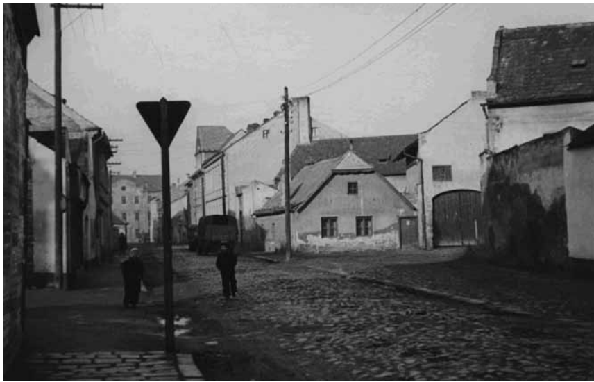
▲ Jižní část Staroměstské ulice před zahájením demolic.
