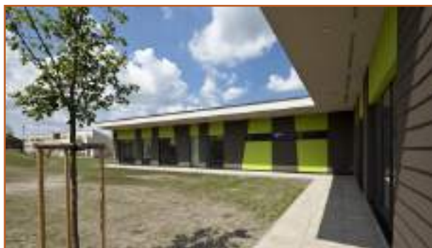
OBRÁZEK ČÍSLO 79: POHLED NA MŠ JENŠTEJN (PŘÍKLAD REALIZOVANÉHO PROJEKTU NA ÚZEMÍ ČR)
