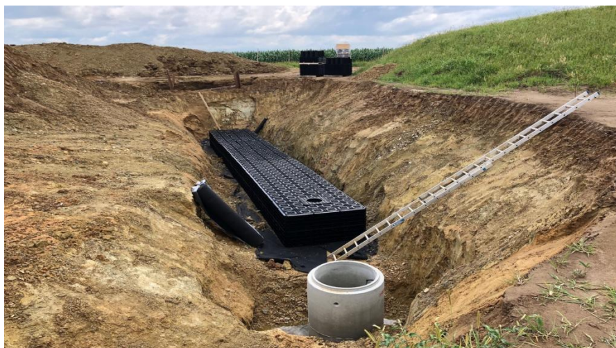
Zasakovací objekt (krecht) u nové výstavby bytových domů – U. Hradiště – Sluneční terasy (ST Development)
