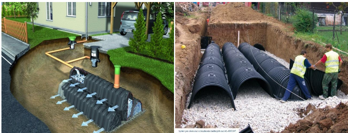
Zasakovací objekt (krecht) u nové výstavby bytových domů – U. Hradiště – Sluneční terasy (ST Development)
